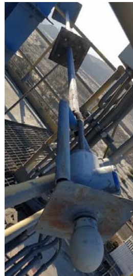
MONTAJE TRANSMISOR DE NIVEL OPTIWAVE 6400 STOCK PILE EN CHILE ALTURA 35 m
